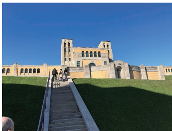
R.C.ハリス浄水場
